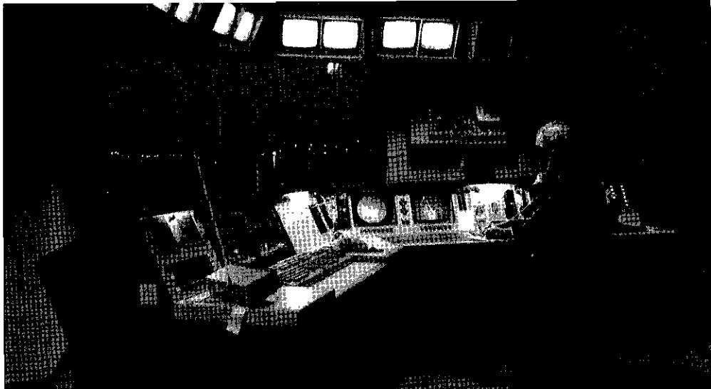
Deel van het bedieningscentrum op de Middelsluis bij Terneuzen
